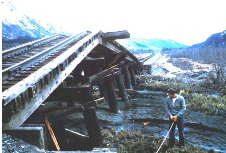
شکل ۴-۱- خرابی پل راه‌آهن واقع بر روی دریایچه‌ی Kenai در طی زلزله‌ی آلاسکا
