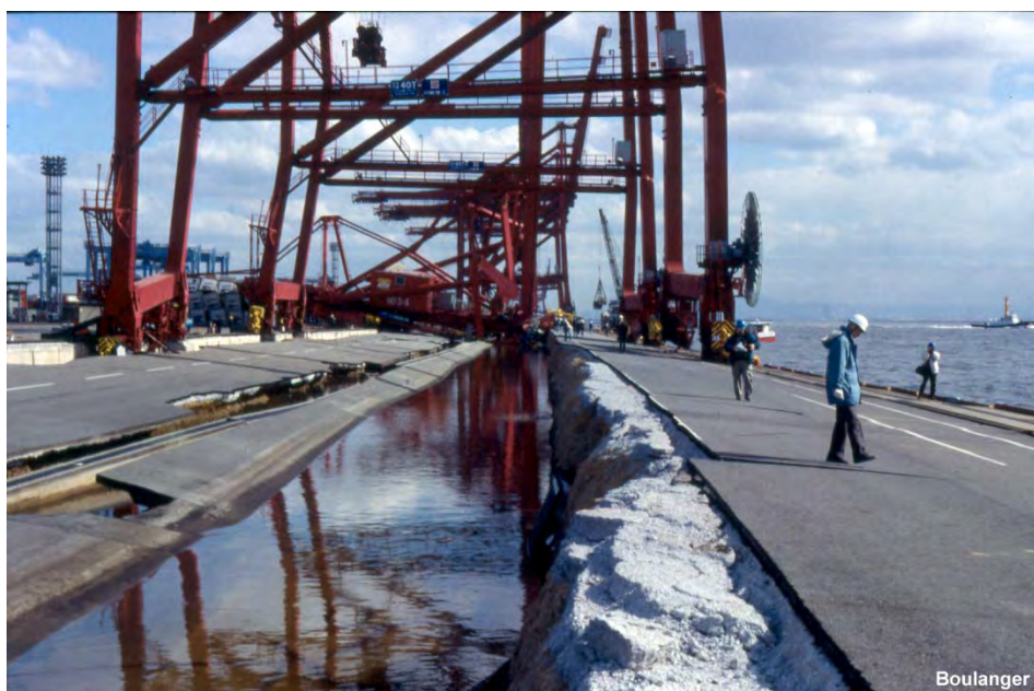
شکل ۲-۱۰- فرورفتگی زمین در پشت دیوار بارانداز در اثر حرکت و دوران ناشی از وقوع روانگرایی
