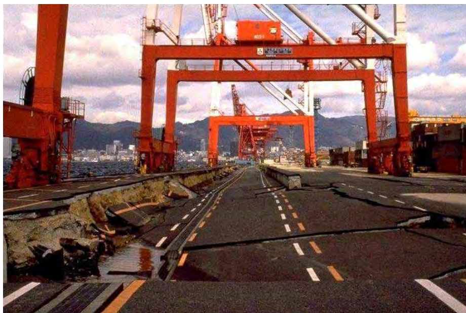
شکل ۱-۱۲- گسترش جانبی دیوار ساحلی در جزیره Port Island در زلزله‌ی کوبه
