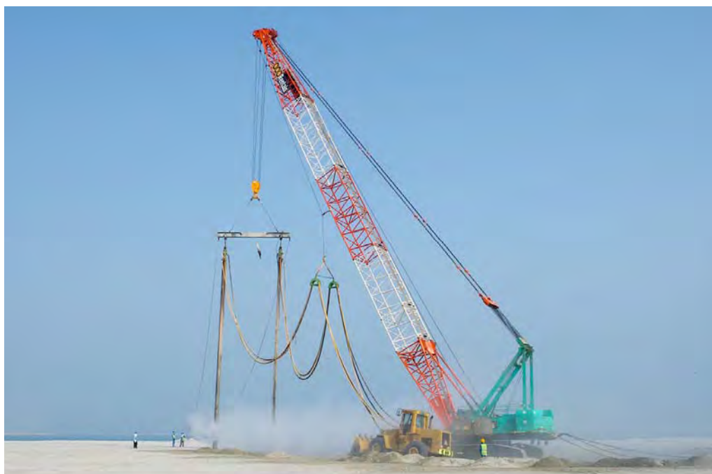
شکل ۸-۸- وسیله‌ی ارتعاشی آویزان از یک جرثقیل معمولی
