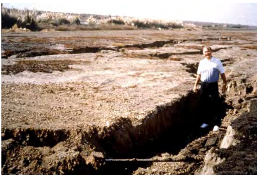
شکل ۴-۲-۵- فرورفتگی زمین در اثر وقوع گسترش جانبی در طی زلزله‌ی سال ۱۹۸۹ Loma Prieta
