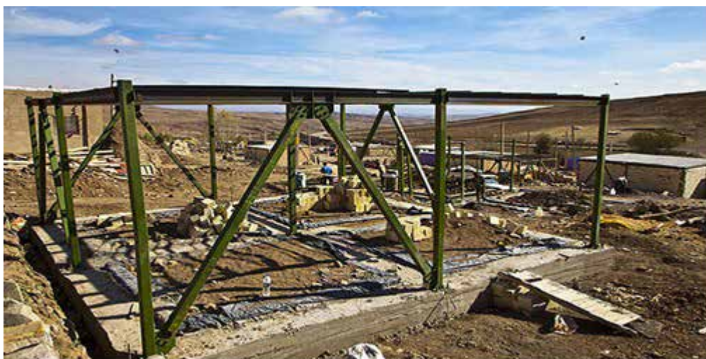
قاب فولادی با پیچ‌ومهره (قاب‌های فولادی در کارخانه ساخته می‌شوند)
