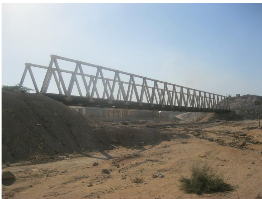
شکل ۱۲-۸- عرشه‌های میان‌گذر بدون مهاربندی جانبی یال فشاری
