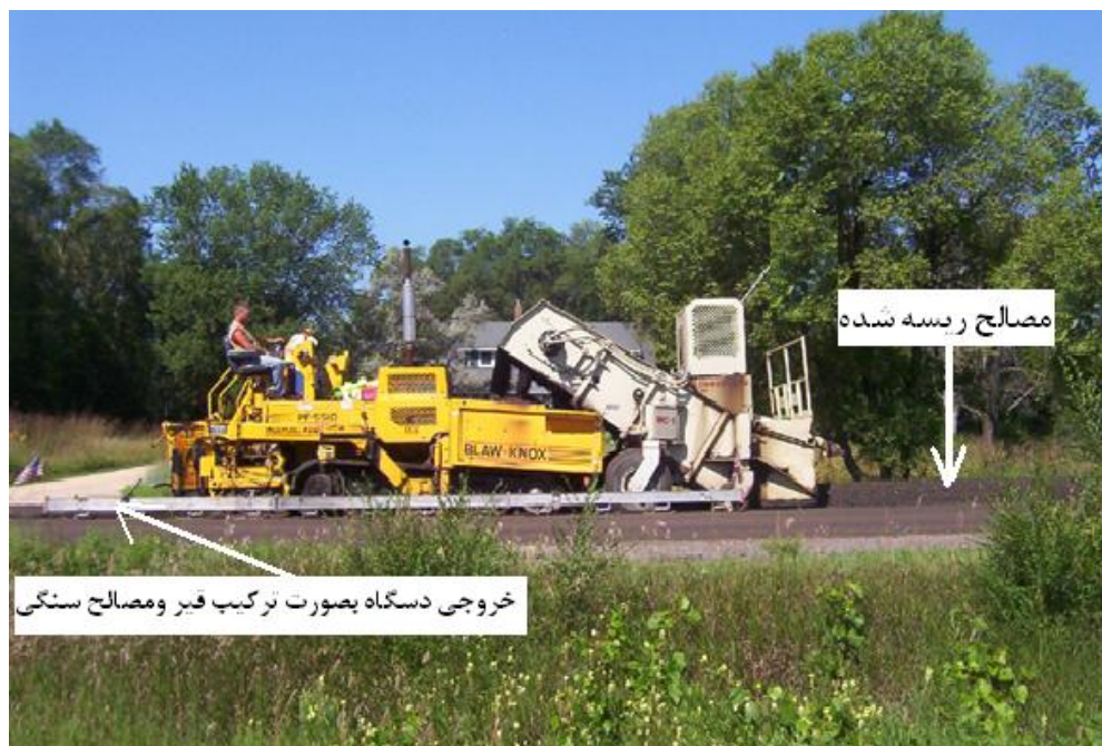
شکل ۵-۳- نمونه‌ای از دستگاه‌های مخلوط‌کننده سیار که عمل جمع‌آوری مصالح سنگی ریسه‌شده در طول مسیر، اضافه‌کردن قیر در داخل محفظه و پخش آسفالت سرد را انجام می‌دهند.
