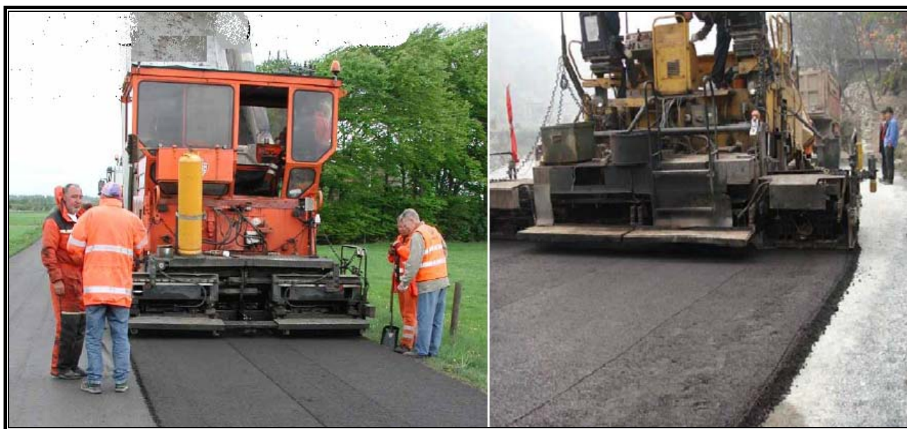
شکل ۵-۹ پخش آسفالت سرد توسط دستگاه فینیشر
