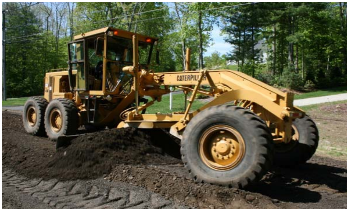
شکل ۵-۵- عمل اختلاط قیر و مصالح توسط گریدر
