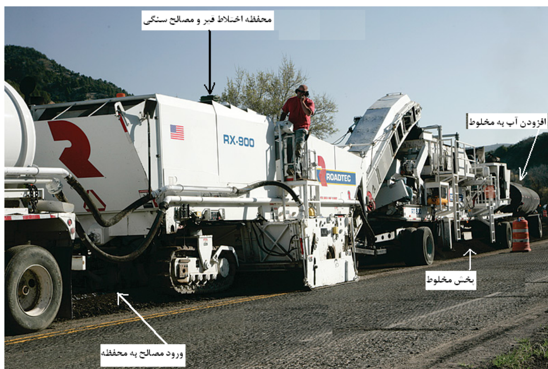
شکل ۵-۴- نمونه‌ای از دستگاه مخلوط‌کننده چرخشی عمل جمع‌آوری مصالح سنگی ریسه‌شده در طول مسیر، اضافه‌کردن قیر در داخل محفظه و پخش آسفالت سرد را انجام می‌دهند.
