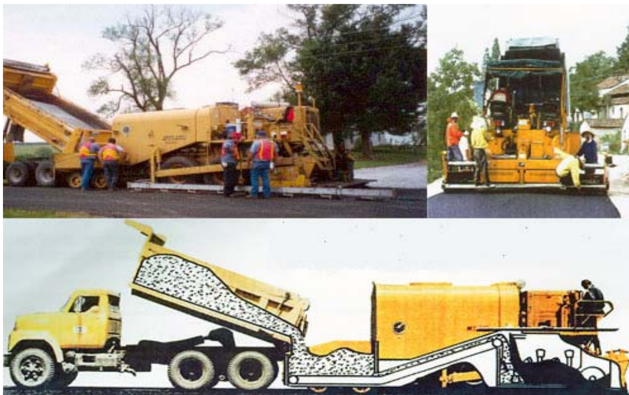
شکل ۵-۶- پخش آسفالت سرد توسط دستگاه فینیشر
