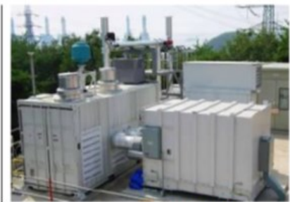
سیستم DFC300 توان ۳۰۰ کیلووات در ولتاژ ۴۸۰ ولت و فرکانس ۵۰-۶۰ هرتز. دمای خروجی حدود ۳۷۰ درجه سانتیگراد با دبی خروجی ۱۸۰۰ کیلوگرم در ساعت می باشد. این معادل تولید همزمان ۱۴۰ تا ۲۳۵ کیلووات می باشد
