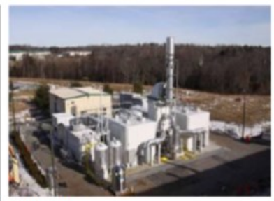
سیستم DFC3000 شرکت FuelCell Energy بزرگترین نیروگاه DFC است که متشکل از ۲ سیستم ۴ مازوله می باشد
