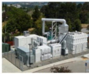
سیستم DFC1500 شامل واحد بازیافت آب، تعدیل بار الکتریکی، مازول پیل سوختی، گوگردزدایی و تولید همزمان ۶۵۰ تا ۱۱۰۰ کیلووات با دبی ۸۳۰۰ در دمای ۳۷۰ درجه سانتیگراد می باشد.
