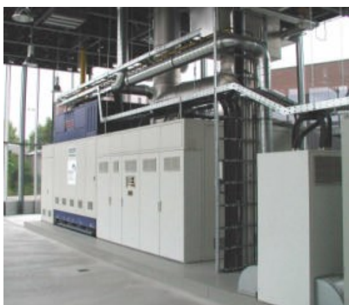
شکل ۲-۳۹: سیستم ترکیبی ۱۰۰ کیلووات SOFC
