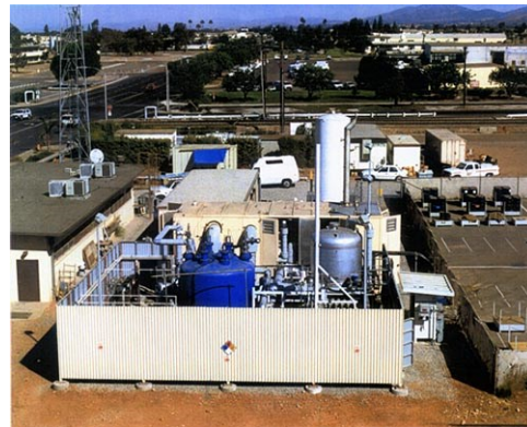
شکل ۲-۵۶: استفاده از پیل سوختی کربنات مذاب در نیروگاه خانگی
