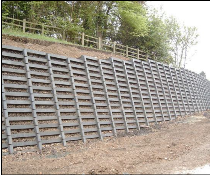
شکل ۱۱-۸ - نمونه‌ای از دیوار حائل صندوقه‌ای اجرا شده
