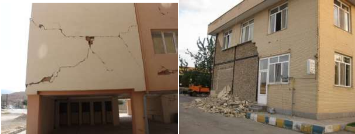
شکل ت ۹-۴- آسیب وارد شده به دیوارهای غیرسازه‌ای (الف) ترک‌های افقی و مورب در دیوار غیرسازه‌ای (ب) عدم مهار مناسب دیوار نما، جداسدن و ریزش دیوار در زمان زلزله
