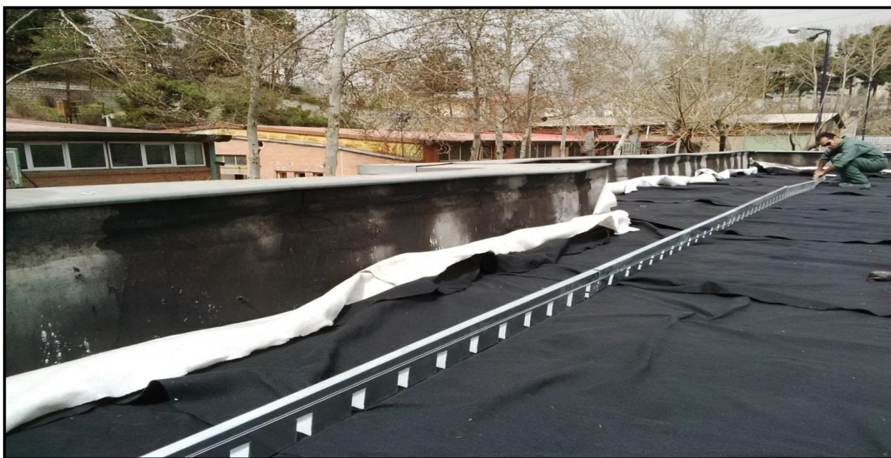
شکل پ.۱-۱۰- قرار دادن جداکننده‌های گالوانیزه در امتداد حدفاصل مسیر حرکت و فضای سبز؛ قطعات ساخته شده در یک دیگر فرو رفته و یک امتداد را شکل می‌دهند.
