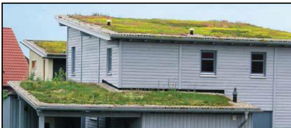
شکل ۲-۱۱- اجرای بام سبز در سقف شیب‌دار
